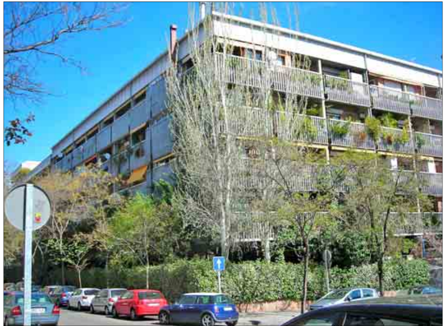
Imagen del edificio que Ricardo Aroca proyectó en la calle de Ángel Muñoz, de Madrid. / JOSE F. LEAL
